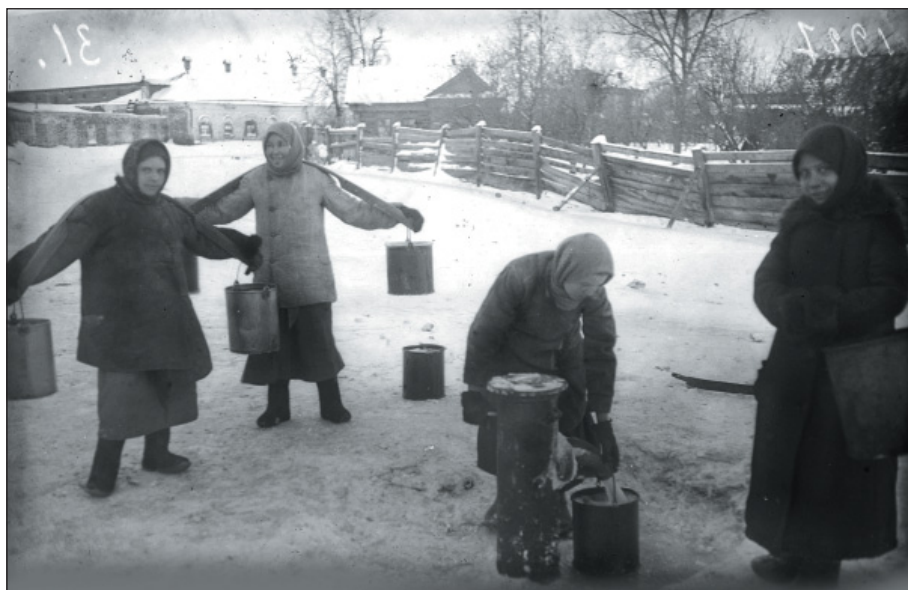
Водоразборные колонки в Адмиралтейской слободе г.Казани. Фото В.Л.Лаптева. Начало XX в. ИМ РТ, КП-18480/14330
